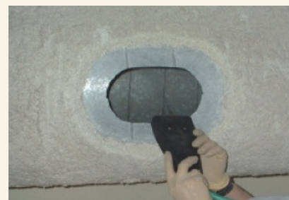
Découpe à la grignoteuse électrique
